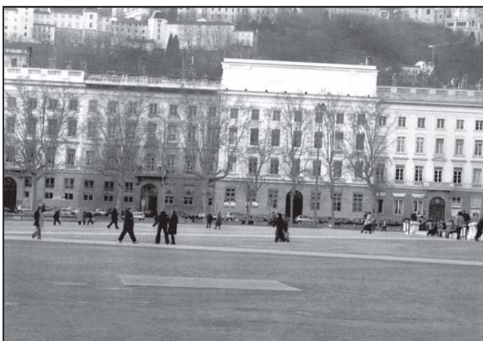
Place Bellecour.....côté jardin...(Photo J-L PAVY)
