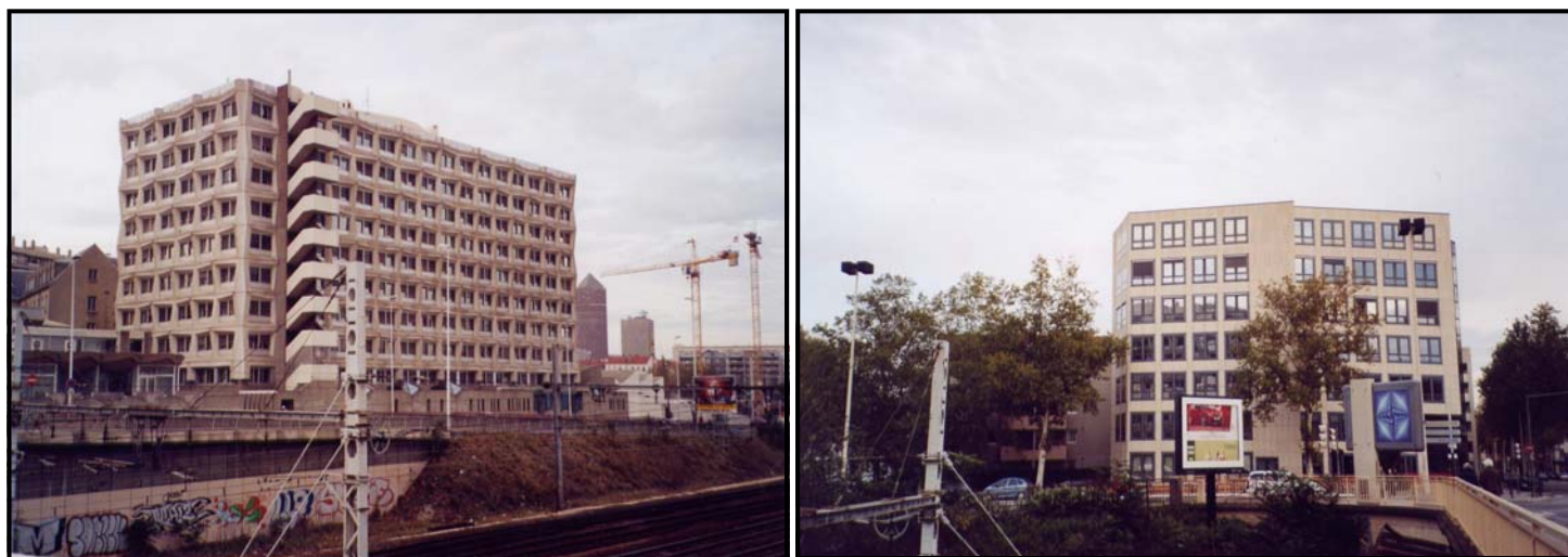
Entre ces deux immeubles : un espace pour jeter une esplanade au dessus des voies ferrées et réussir la trame urbaine. Croisée Gambetta—Vivier Merle—Mouton Duvernet (Photo J. Bonnard)
